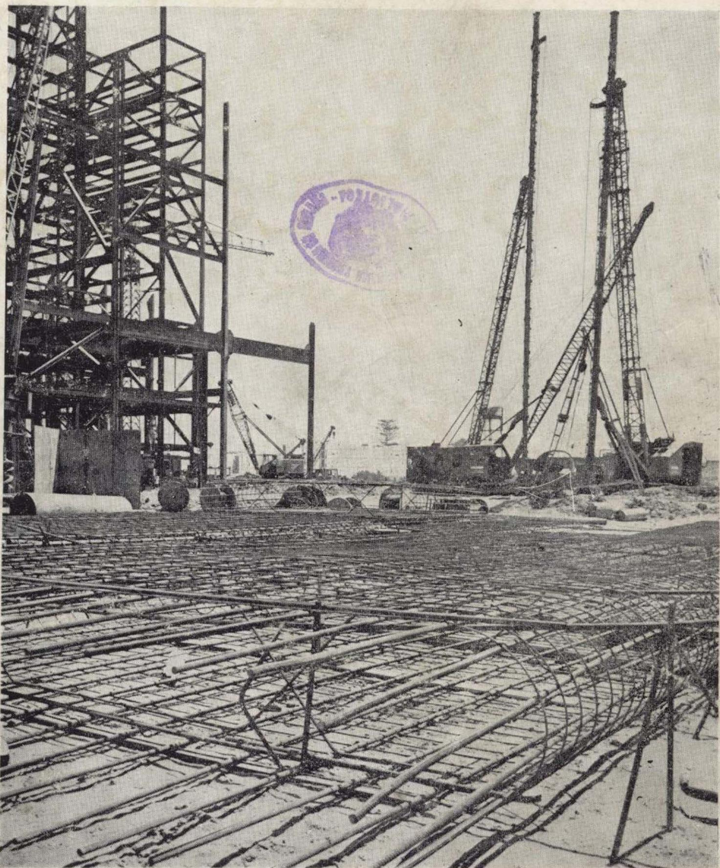
CENTRAL TERMICA DE ALGECIRAS. Compañía Sevillana de Electricidad. Cimentación del 2.º Grupo mediante pantalla continua y pilotes planos de 80 cm. de espesor y profundidad 25 mts. Medición total ejecutada: 5.924 m<sup>2</sup>.
